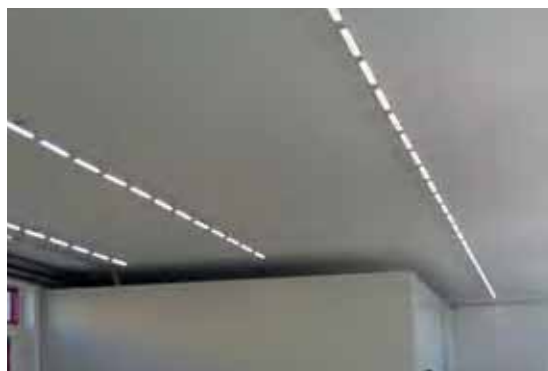
GARAGE PALAZZINA DEL SOLE | Asti
