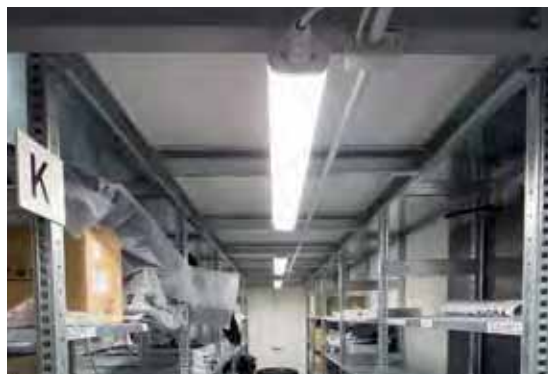
MAGAZZINO / WAREHOUSE | Repubblica Ceca
